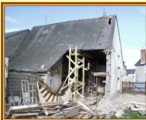
De gros travaux pour la transformer en bibliothèque
