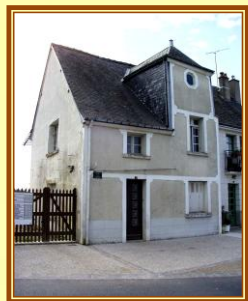
La maison de Lucien Brossard
